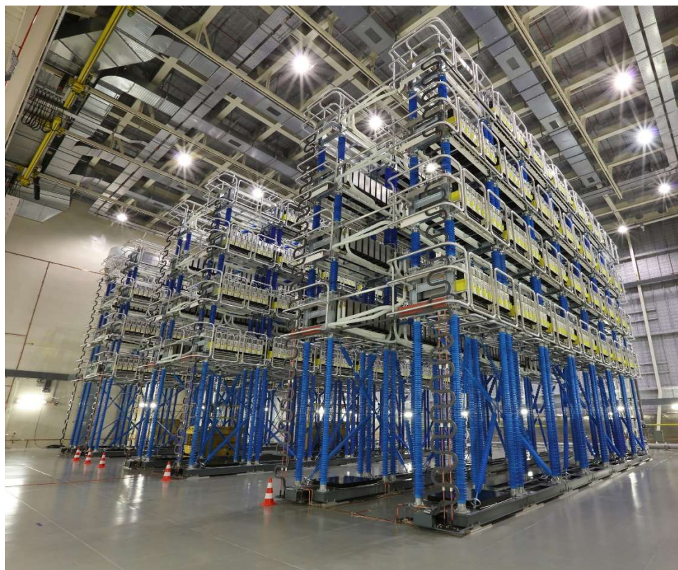
Рисунок 6 – Конверторы ППТ Dolwin 3 размещенные в клапанном зале
